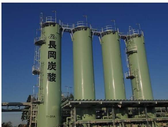
<液化炭酸ガス製造プラント>
